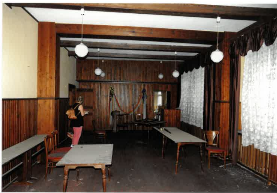
31. Jedno z pomieszczeń drugiej kondygnacji nad częścią usługową.
