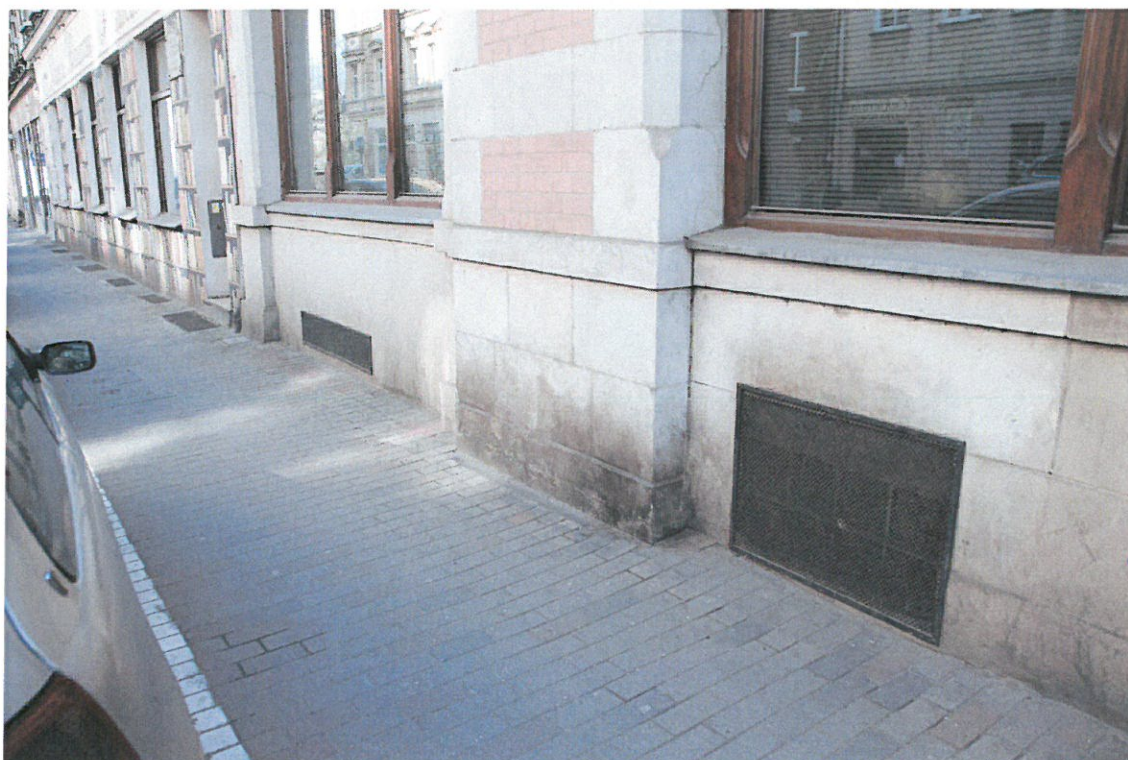
Fot.2. Widok dolnej części ściany zewnętrznej od ul. Łokietka.
