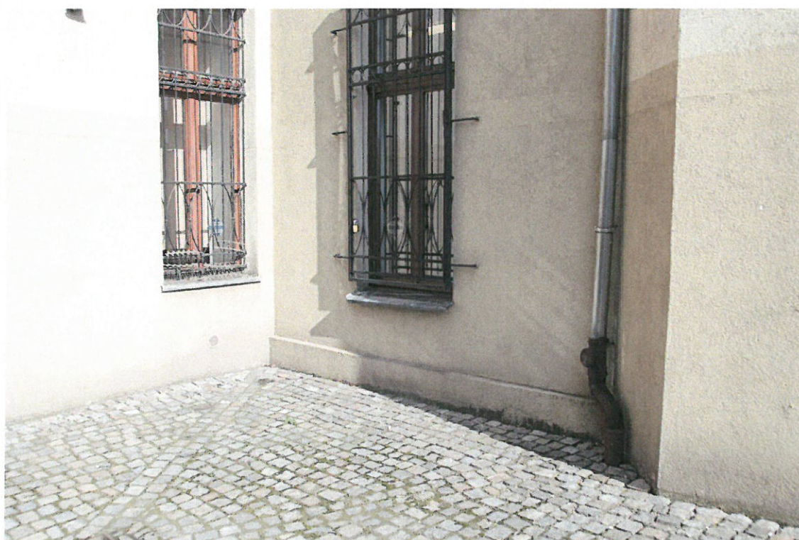
Fot. 3. Ściany zewnętrzne od strony dziedzińca.
