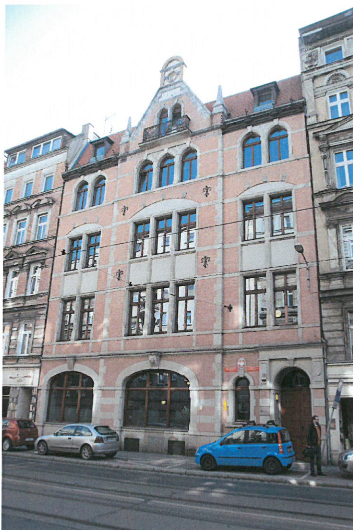
Fot.1. Elewacja frontowa kamienicy przy ul. Łokietka 11.
